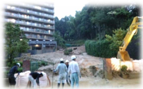
土砂撤去作業
